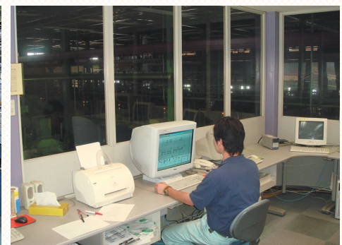
FAラインを集中コントロールする制御室
